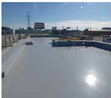
屋上の防水工事
