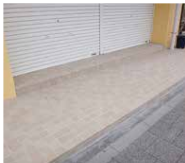
タイルの張り替え
