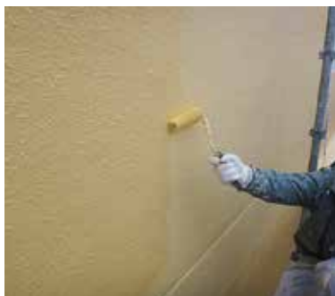
外壁の塗装・防水コーティング
