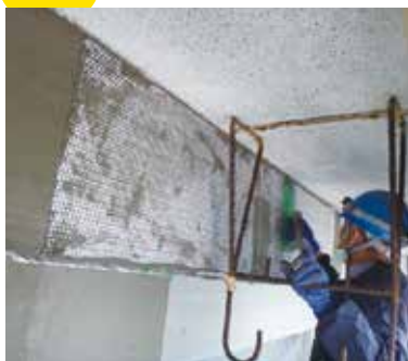
外壁のひび割れ直し
