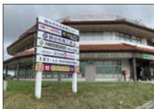
巨大で立派な農協の建物
