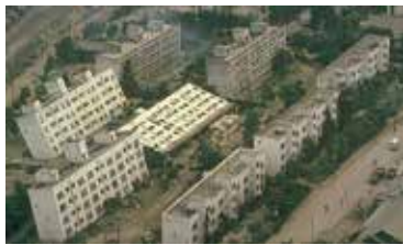
新潟地震にて大きく傾いたアパート。「液化化で噴出した水により延焼が食い止められた」「免震として機能し揺れを弱めた」など被害を軽減する作用も生じていたと言われています。
