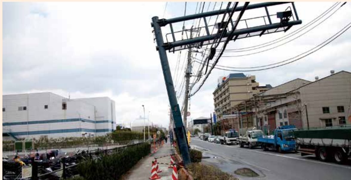
忘れもしない2011年3月11日。大きな地震が長く続いたことによって発生したとされる「液状化現象」が発生しました。(写真は運動公園前交差点付近)
