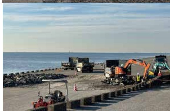
傷んだ舗装や空洞を埋める工事
